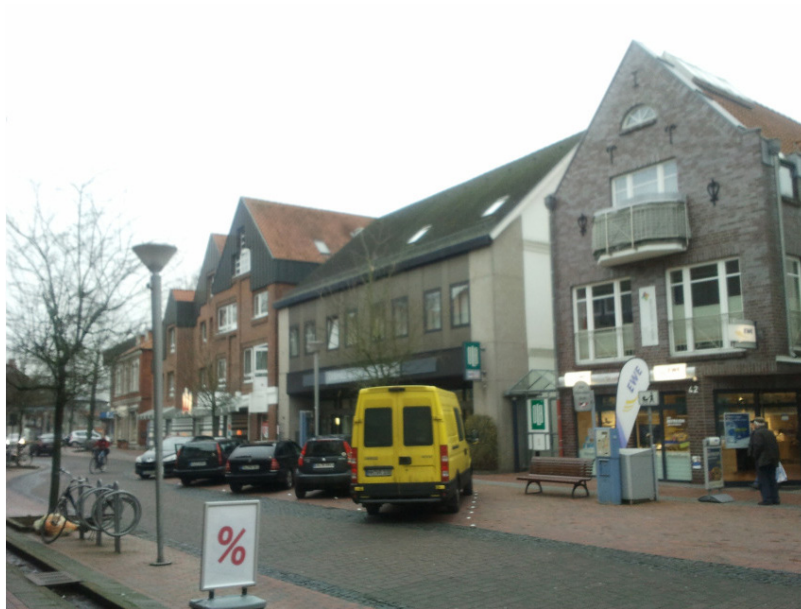
01 Bestehendes OLB Gebäude
