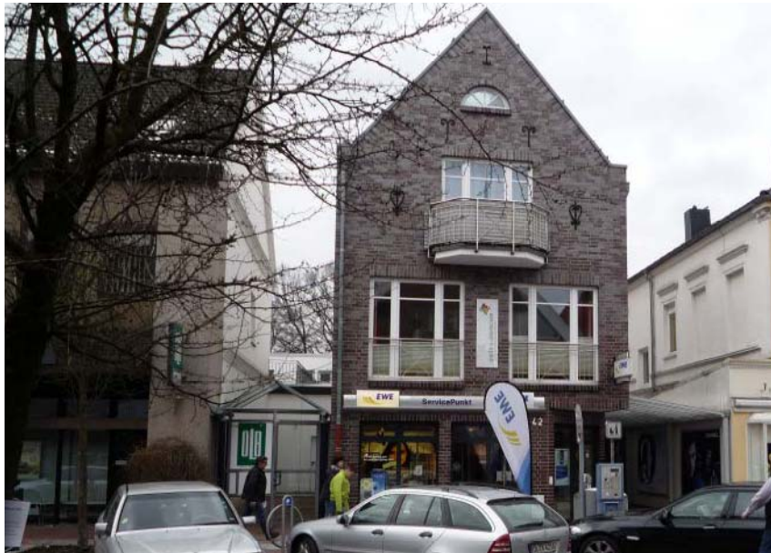
03 Bestehende Nachbarbebauung zur Rechten (EWE-Gebäude)
